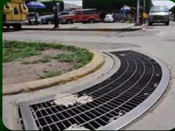
Ilustración 25: Ejemplos de bocas de tormentas Fuente: News Network Communication Mexico, 2013
